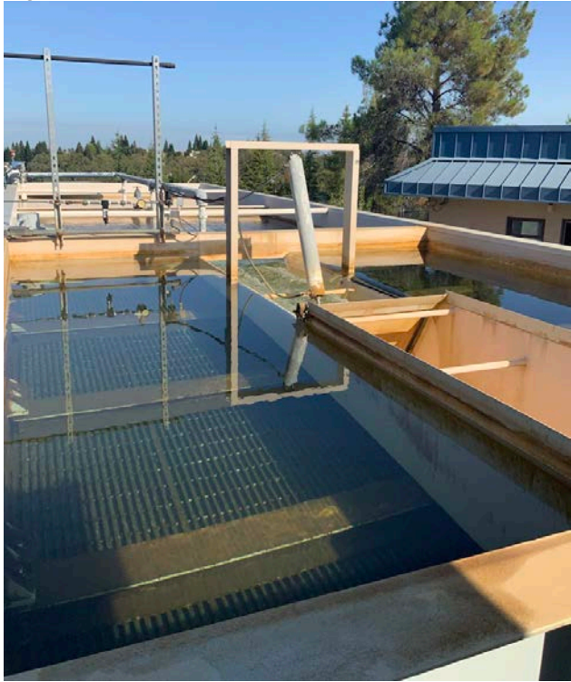
EL DORADO HILLS WATER TREATMENT
